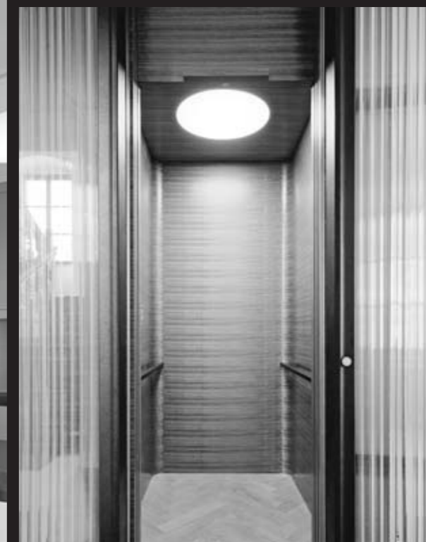
Die Liftkabine ist innen und aussen mit dem im Rathaus allgegenwärtigen Nussbaumholz verkleidet. Schlanke Glasstäbe schirmen den Blick in den Liftschacht ab.
