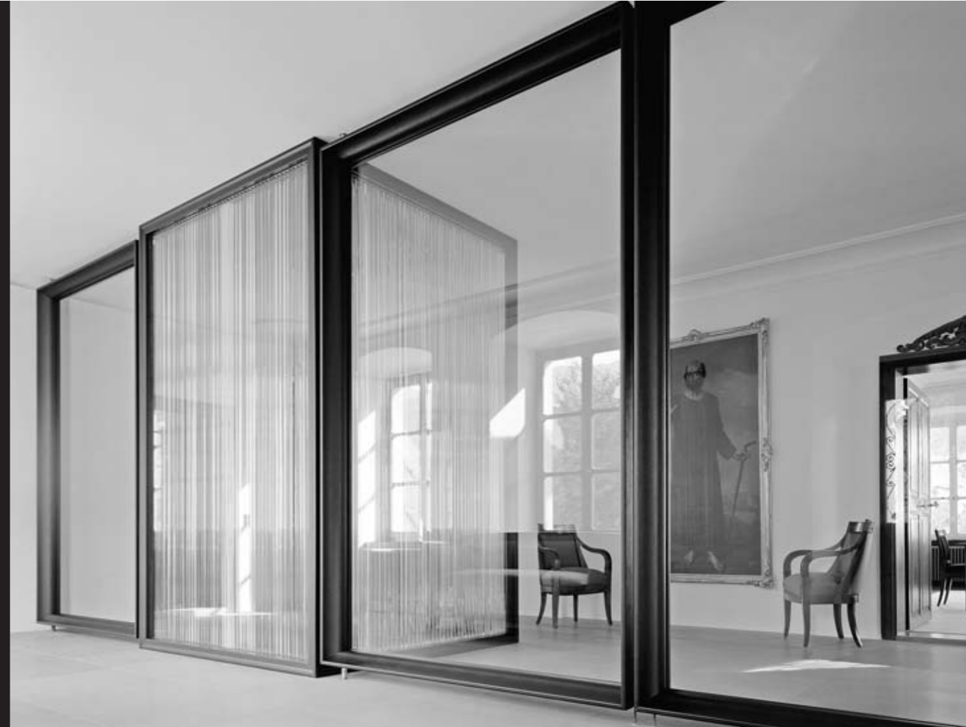
Die neuen Sicherheitsabschlüsse und die Liftschachtverkleidung in lederbezogenen Holzrahmen in der Eingangshalle des 1. Obergeschosses. Im Hintergrund der Regierungsratssaal.
