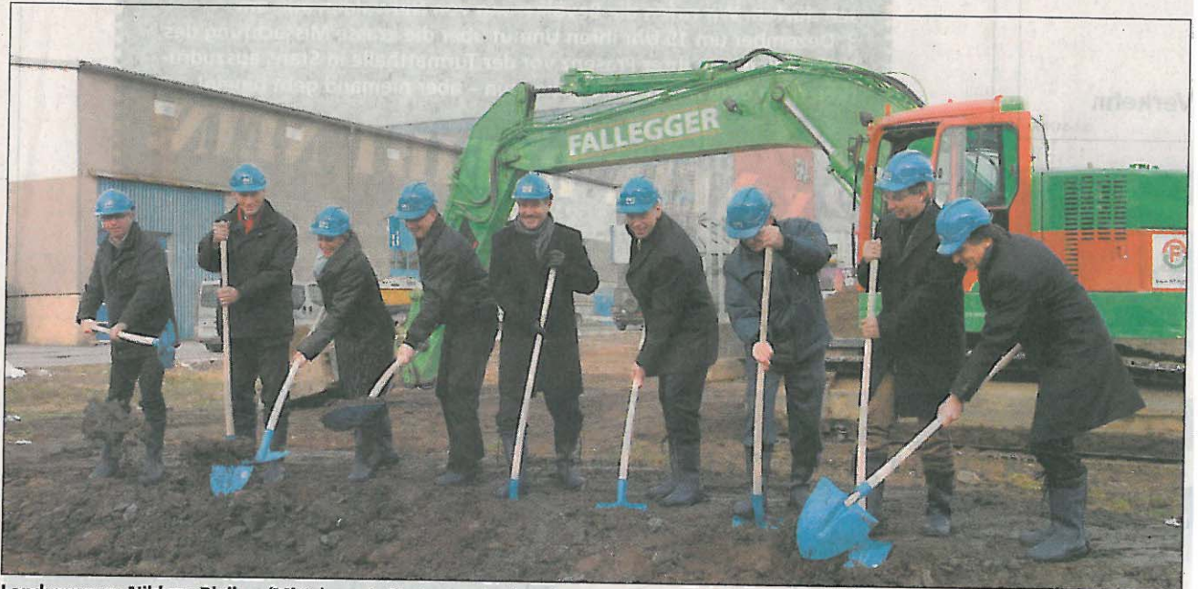
Landammann Niklaus Bleiker (Mitte) sowie Vertreter der beteiligten Firmen und Baufachleute beim Spatenstich.
